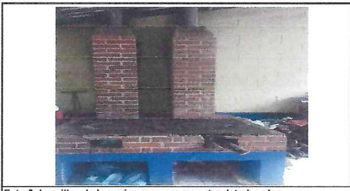
Foto 5: hornillas de la cocina que se encuentra deterioradas.
