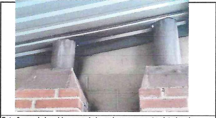
Foto 6: una de las chimeneas de la cocina se encuentra deteriorada.
